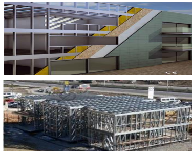
Estructuras de acero ligero, paredes de fibras
