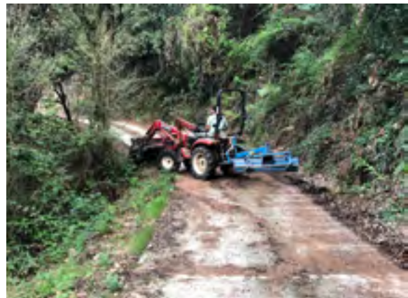
Treballs de manteniment de camins. Font: Arxiu XPN
