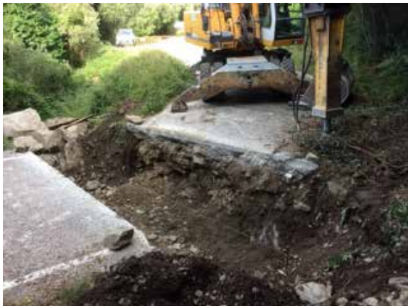
Obres per a l'eliminació de l'antiga infraestructura
