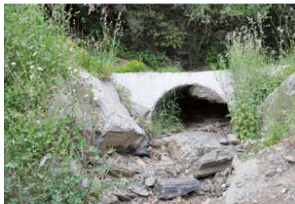
Pas d'aigua semicircular, un any després i que respecta la llera original del torrent i millora la permeabilitat faunística
