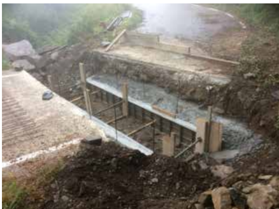
Construcció d'encofrat per la construcció de la nova canalització semicircular
