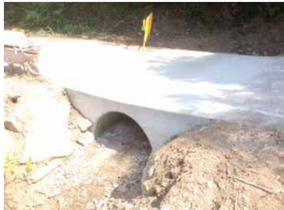
Tipologia de pas d'aigua amb tub estèric que s'ha de substituir
