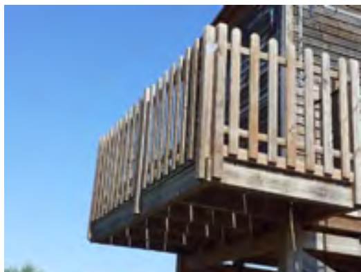
Col·locació d'entornpeu a la balconada. Font: Arxiu XPN
