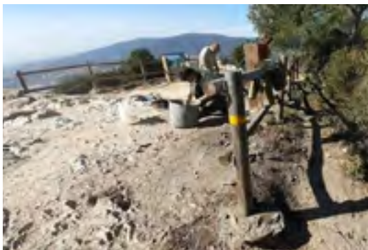
Reparació del Mirador de Montcabrer. Font: Arxiu XPN
