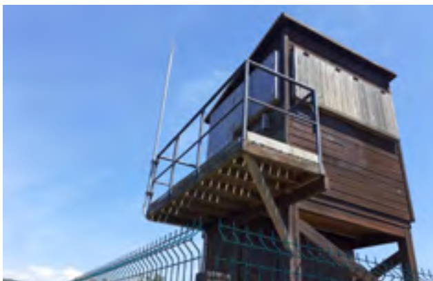
Col·locació d'entornpeu a la balconada. Font: Arxiu XPN
