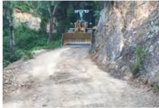
Reparació de la xarxa viària per a la prevenció d'incendis. Font: XPN
