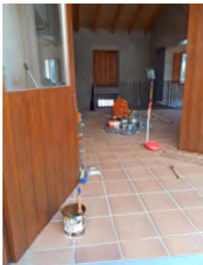
Millora i manteniment de les portes i finestres de Can Bosc. Font: Arxiu XPN
