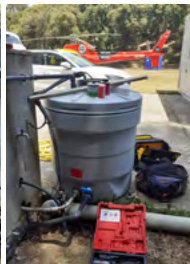
Sistema de cloració de la zona de l'heliport de Can Bosc. Font: Arxiu XPN
