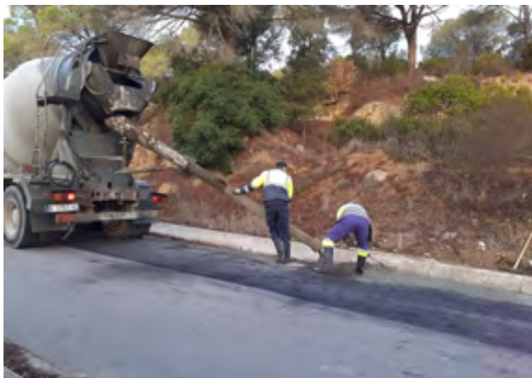
Repàs de l'asfaltat i reparació de les cunetes de formigó de la pista de Can Bordoi a Can Massuet. Font: Arxiu XPN
