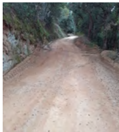
Arranjament del camí de Vallmanya a la zona del Montnegre. Font: Arxiu XPN
