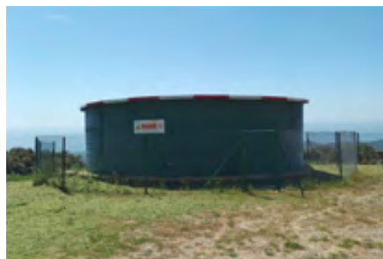
Bassa de prevenció d'incendis de la urbanització. Font Montnegre a Sant Iscle de Vallalta. Font: Arxiu XPN
