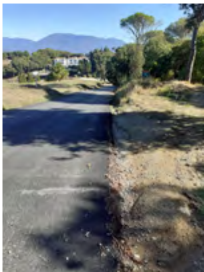
Treballs d'asfaltat de la pujada de Can Massuet. Font: Arxiu XPN
