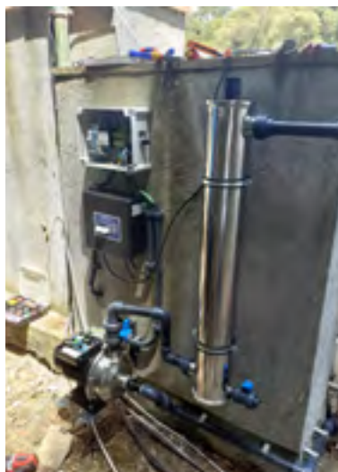
Sistema de cloració de la zona de l'heliport de Can Bosc. Font: Arxiu XPN
