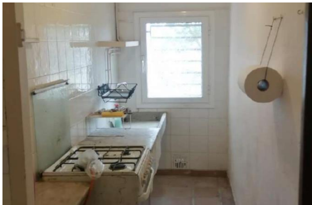
Imatge anterior a la intervenció de rehabilitació
