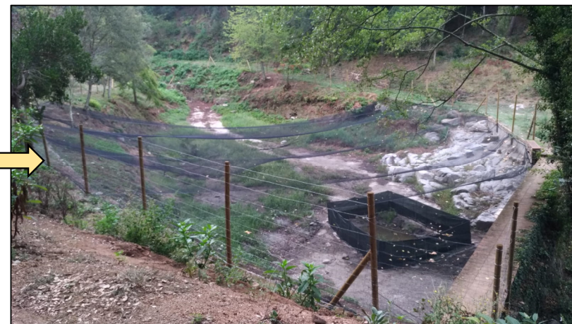
Vallado perimetral + Punto de agua central con trampas
