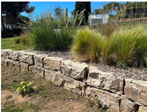
Mur de pedra seca amb vegetació propera
