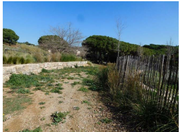
Parets de pedra seca al camí sobre la bassa
