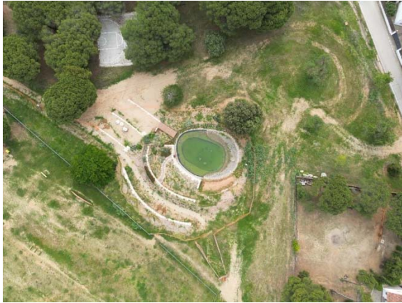
Fotografia aèria en la fase final de construcció
